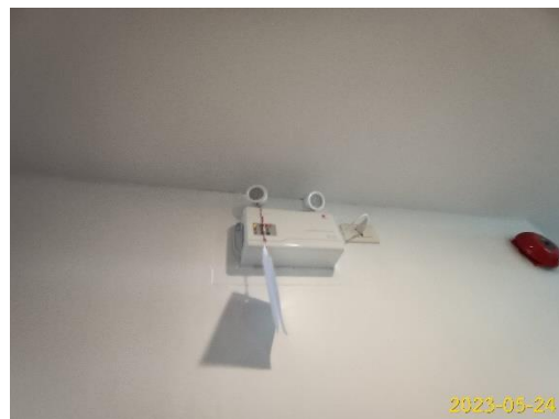
Battery ไฟฟ้าสำรอง
