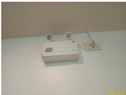
Battery ไฟฟ้าสำรอง
